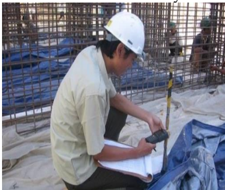
Gambar 6. Pengecekan suhu beton
